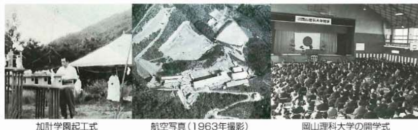
加計学園起工式 航空写真(1963年撮影) 岡山理科大学の開学式
